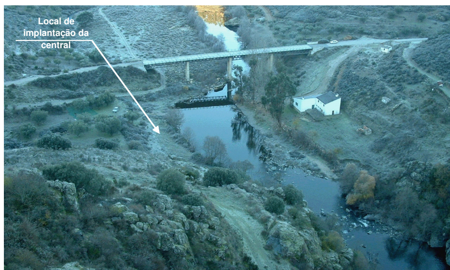
Fotografia 2 – Local de implantação da central do aproveitamento. Vista para jusante da ponte nova (EN 219) sobre a ponte velha.
